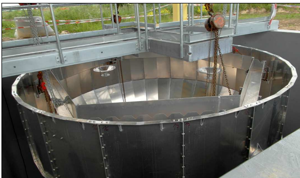
Usazování technologické části
