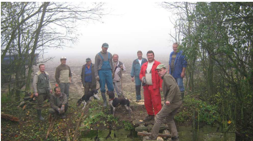
Oprava můstků přes potok u Milešovického remízku
